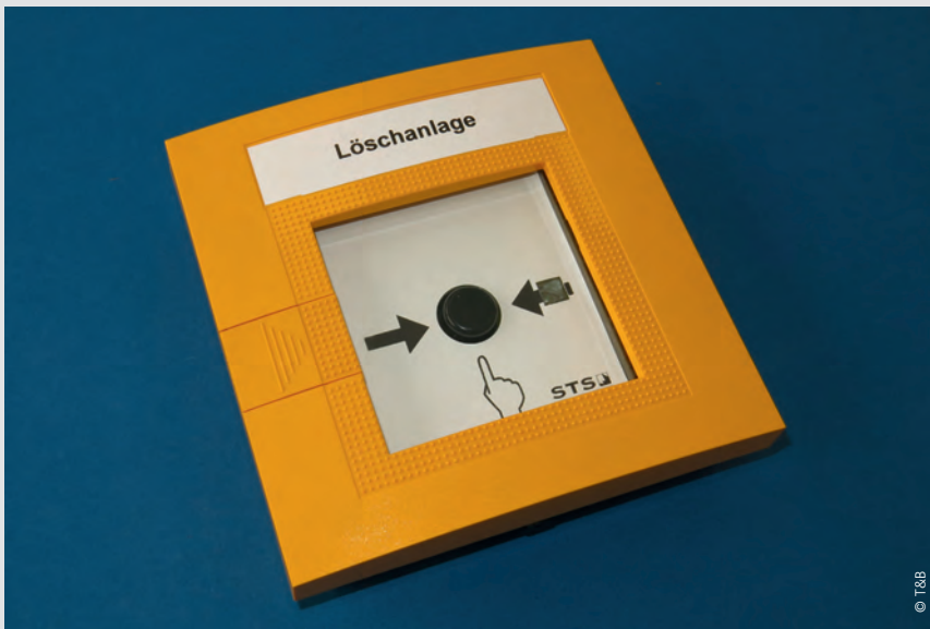
Handmelder zur manuellen Auslösung der Löschanlage.
